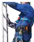
77: líneas de vida verticales y sistemas de seguridad para escaleras
